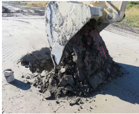
Slika 2. Testno polje (zgoraj levo), s kontrolnimi meritvami doseženih deformacijskih lastnosti (zgoraj desno) in zgoščenosti (spodaj levo), ter izvedbo sondažnega izkopa z odvzemanjem vzorca (spodaj desno) v izvedbi Zavoda za gradbeništvo Slovenije. Avtor: interno gradivo ZAG.
